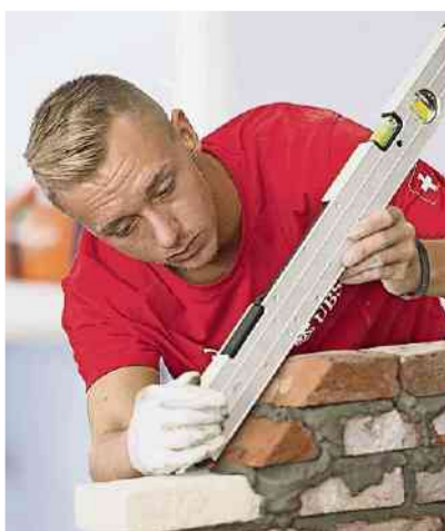
Eine grosse Ruhe beim Mauern: Das ist Kevin Hofers Stärke. Michael Zanghellini/zvg
